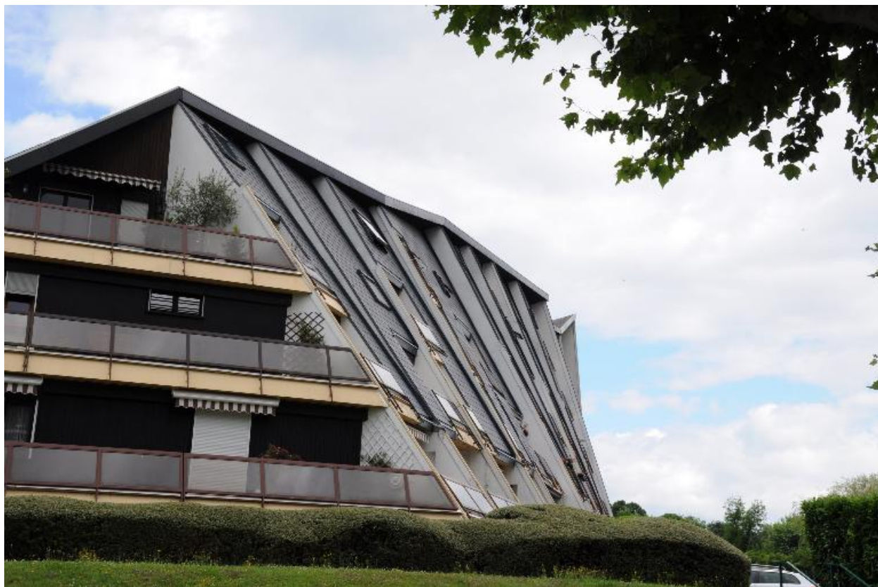
Façade postérieure en éventail : immeuble Les Cygnes
