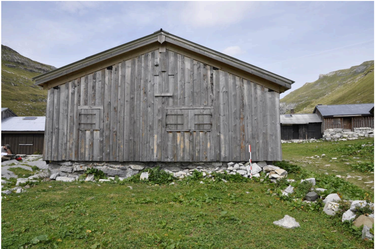
Vue du mur pignon sud
