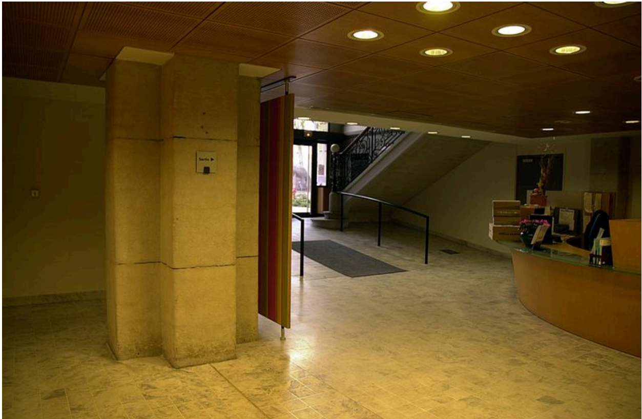
Pilier derrière l'escalier d'honneur, près de l'ascenseur
