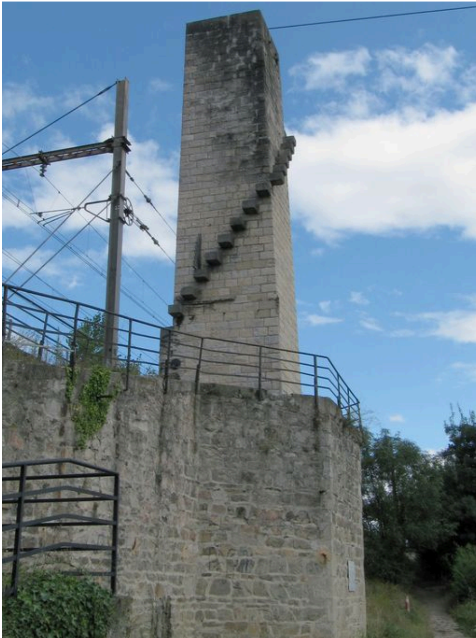
Pile droite, face sud, vue générale du bas du parapet (depuis la rive droite)
