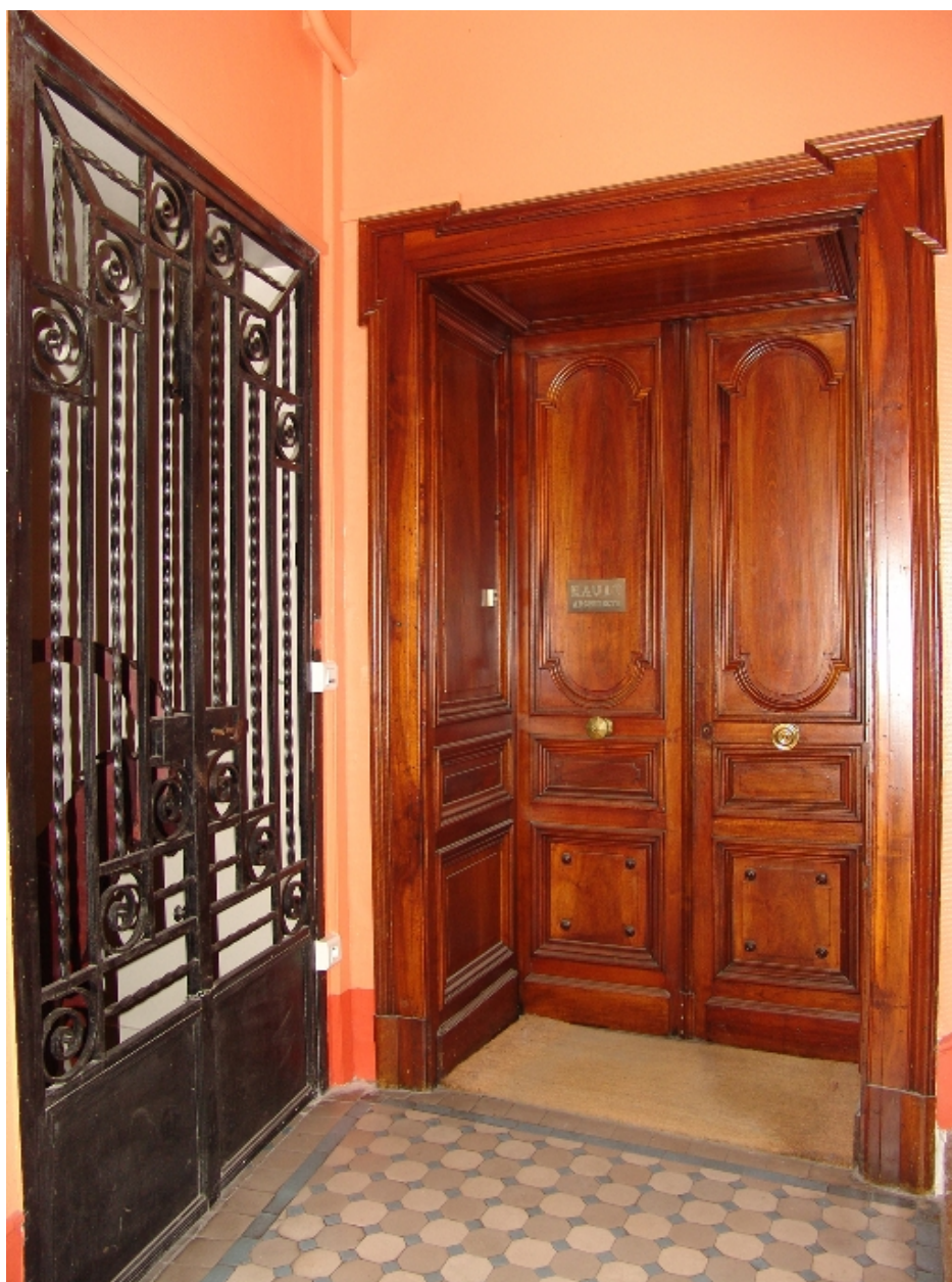
Porte palière du 1er étage
