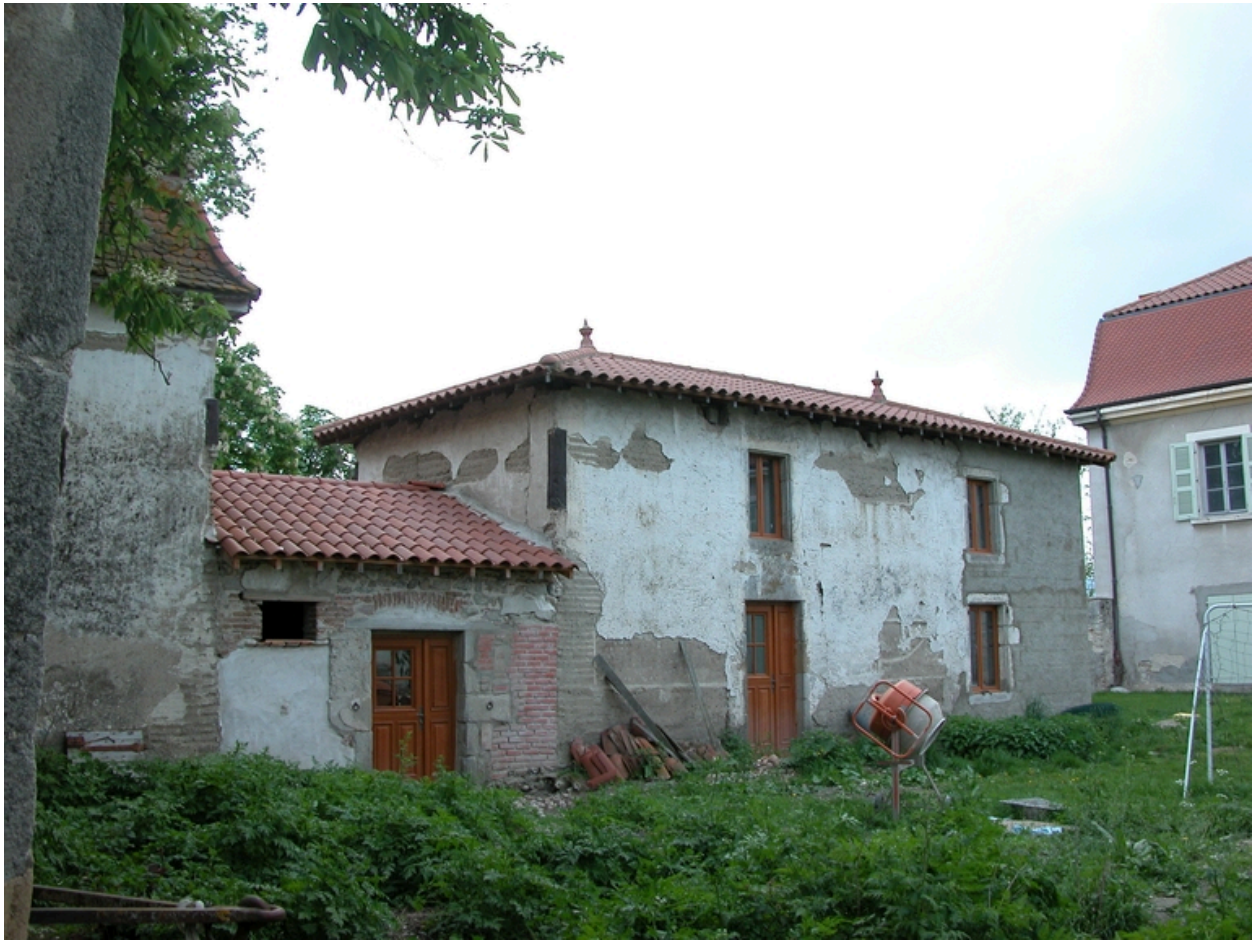
Vue d'ensemble du bâtiment sud des communs, depuis l'avant-cour.
