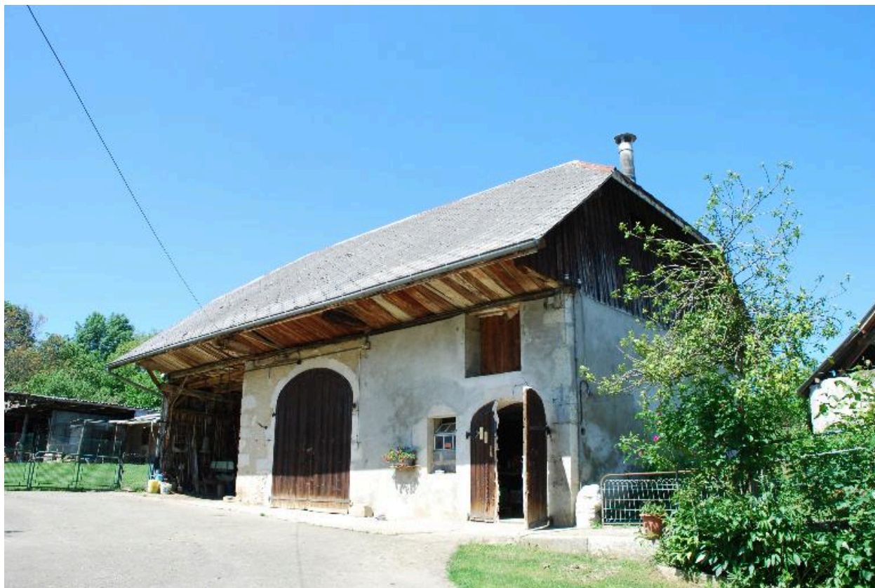
La Plesse, ferme (2013 D2 800), grange-étable de la ferme, vue d'ensemble de trois-quart avant droit.
