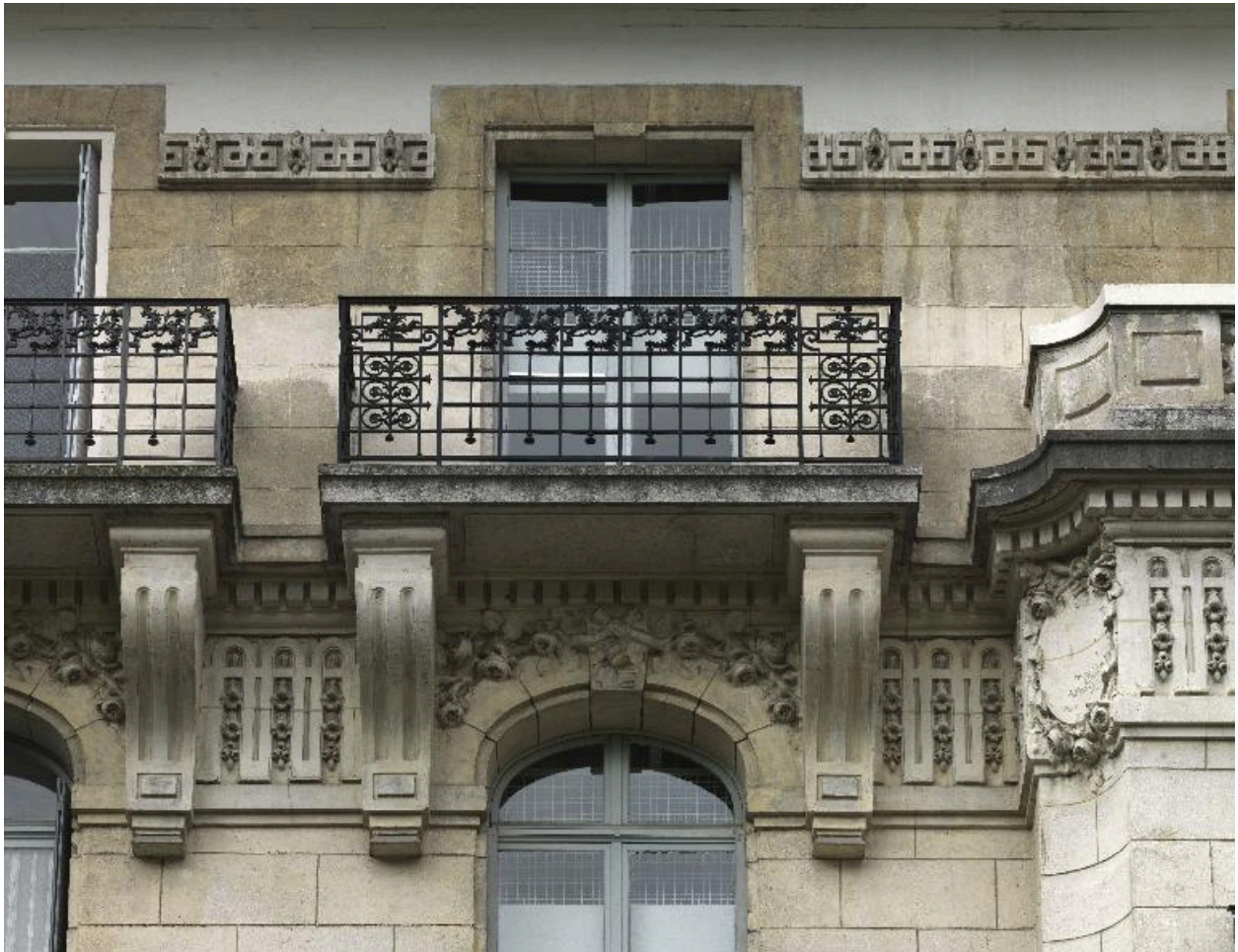
Façade sur cour: baie du 4e étage
