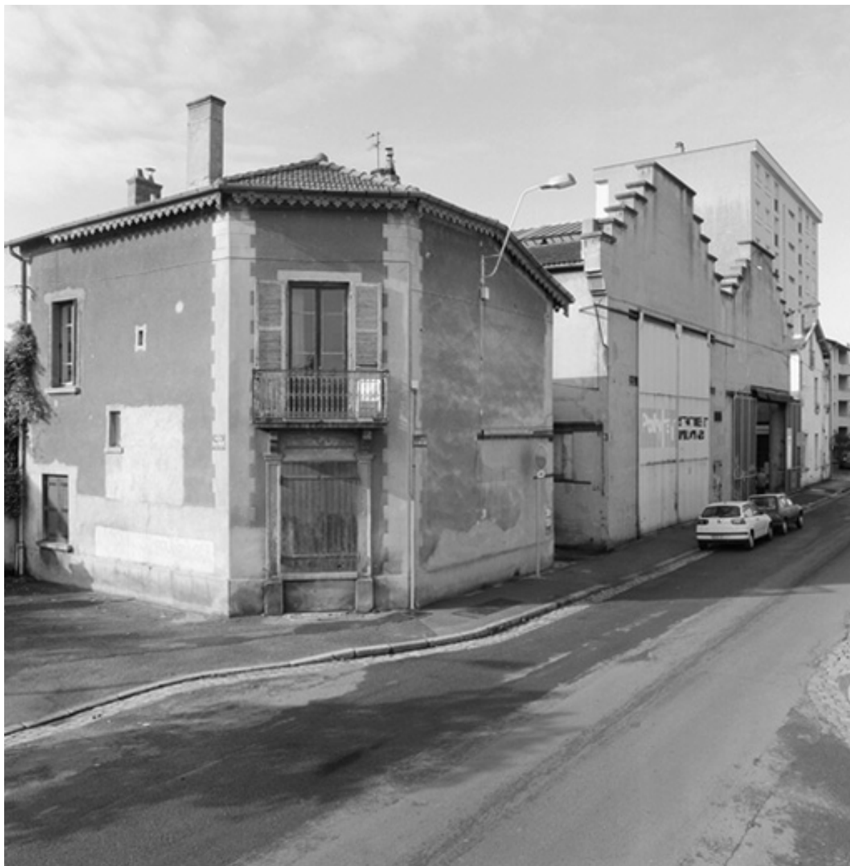
Vue générale nord-est
