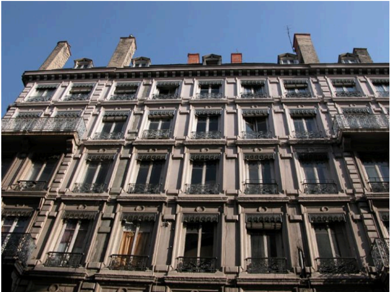
Façade principale rue Grenette, vue par-dessous
