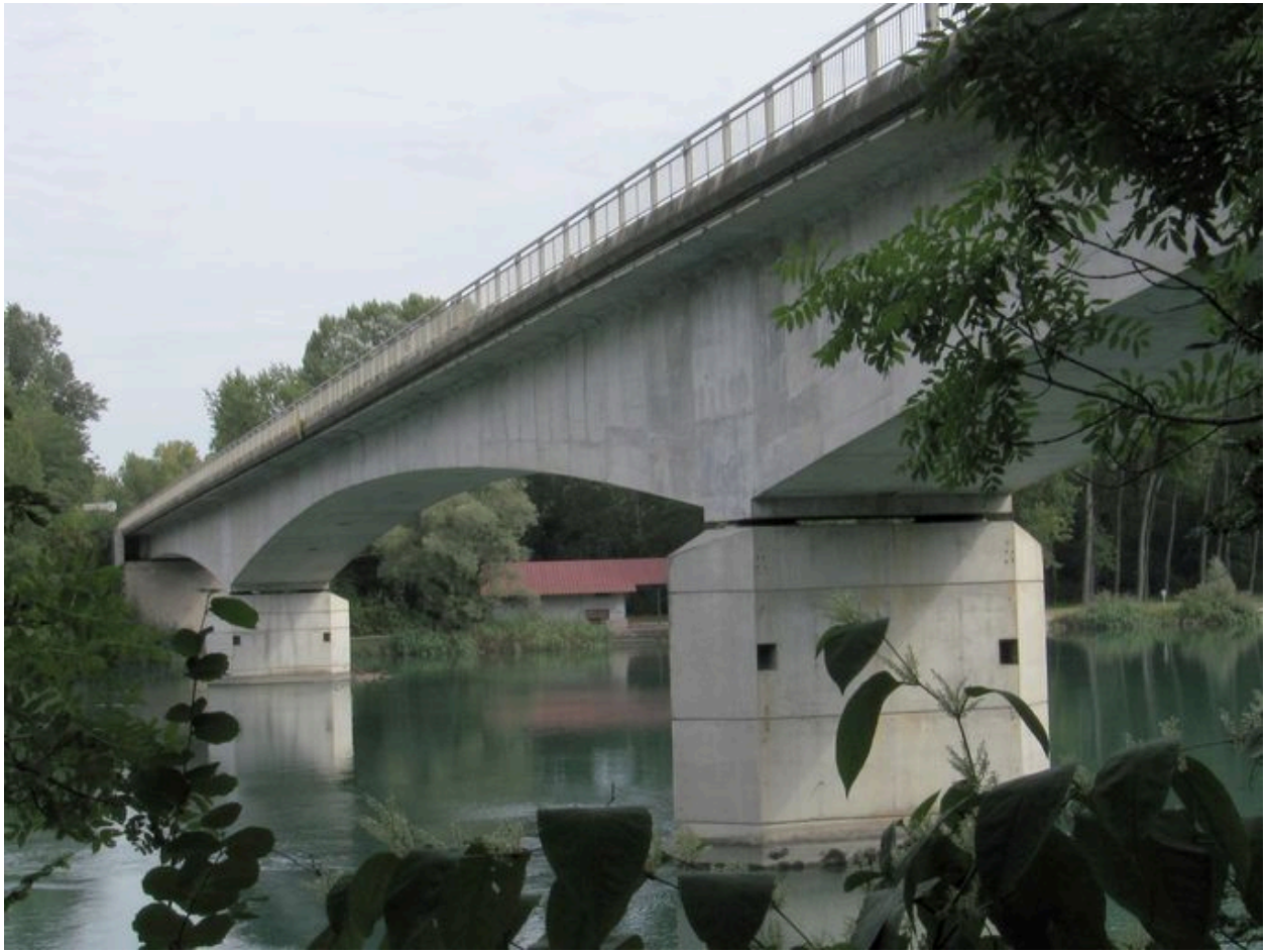
Arche centrale, face aval (depuis la rive gauche)
