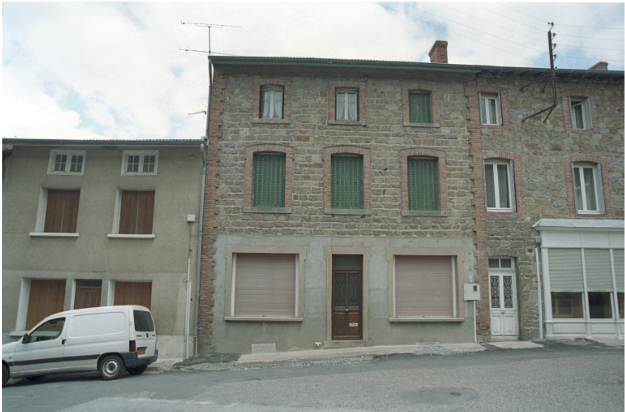
Le Bourg, maison et commerce (1986 C2 745), vue d'ensemble de face. Maison maçonnerie avec encadrement des baies en brique.
