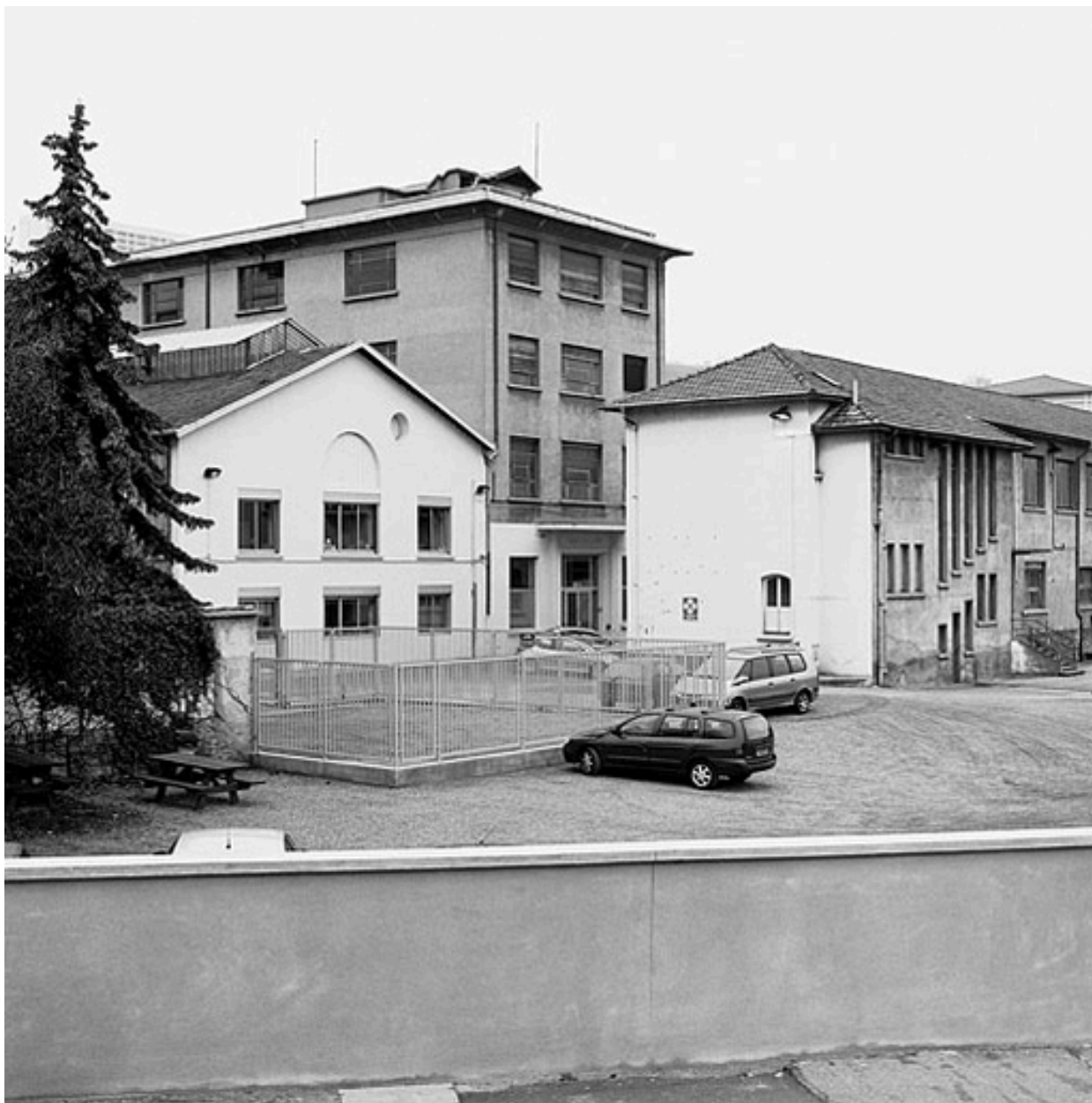
Vue d'ensemble des ateliers est
