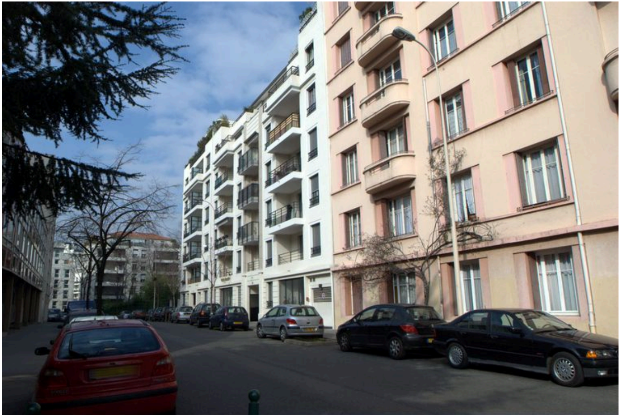
Vue de la partie nouvellement percée de la rue Jules-Brunard, depuis l'angle de la rue Nicolai
