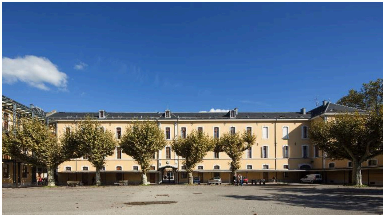
Cour 3 : vue générale vers l'est.
