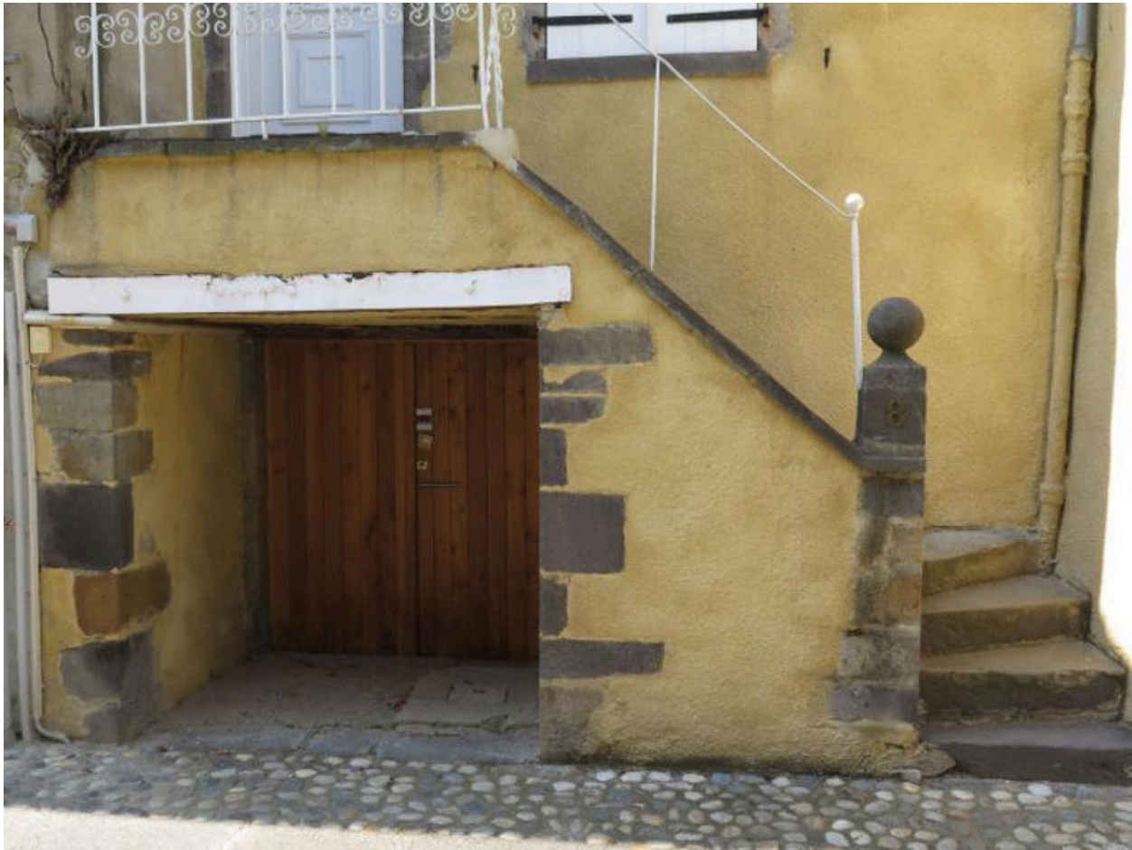
Escalier et entrée de la cave
