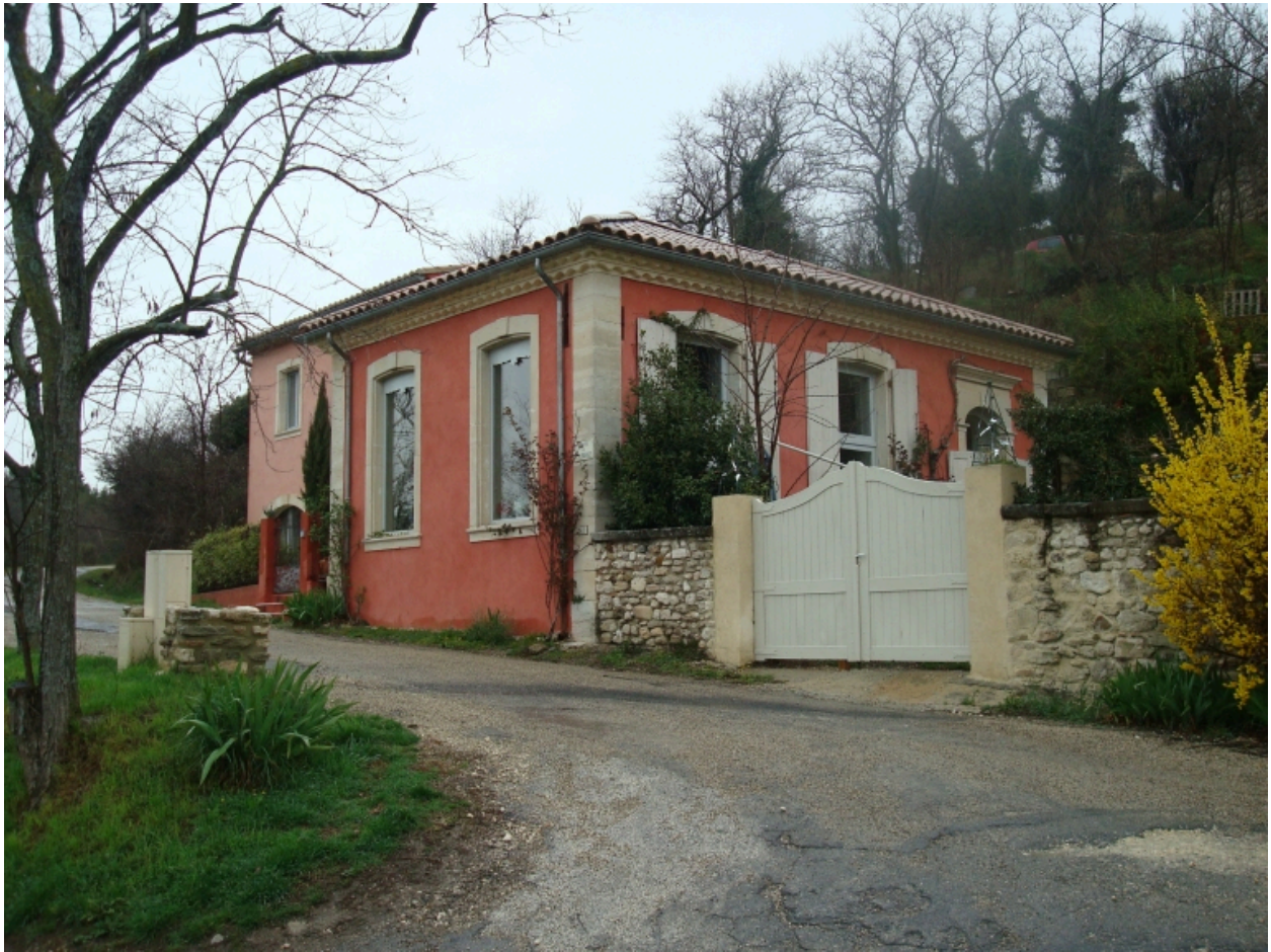
Ancienne école de garçons, convertie en atelier.
