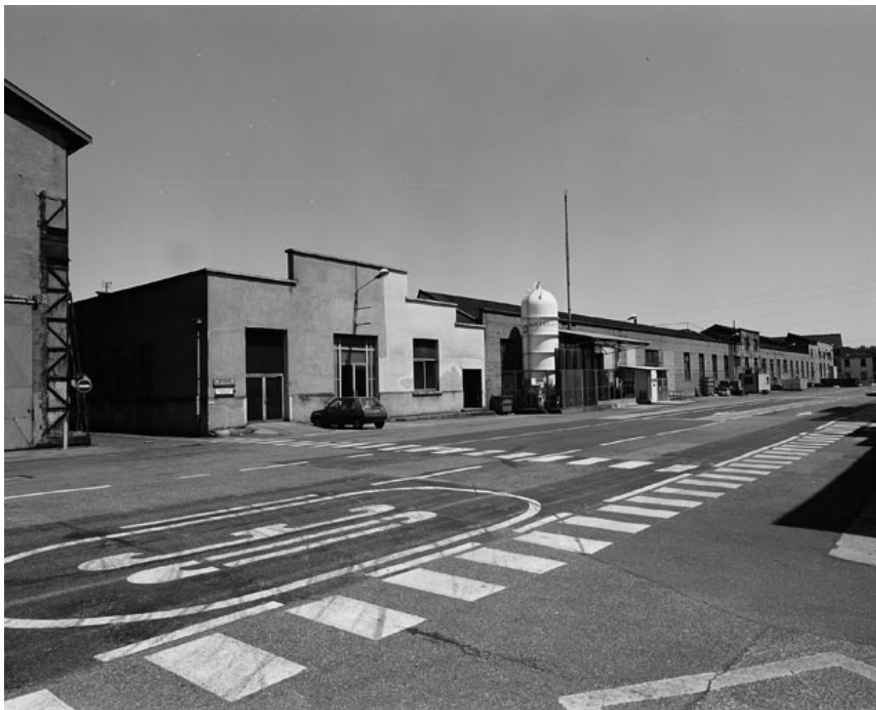
Parachèvement nord, ébardage, avenue B
