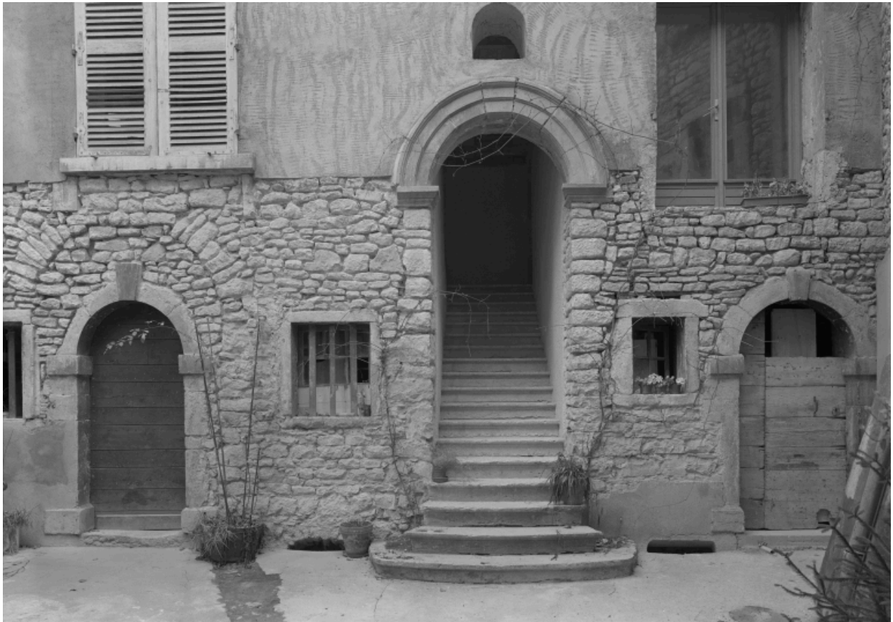
Maison partagée (type IV), 80 Grande rue : élévation sur cour, corps postérieur.
