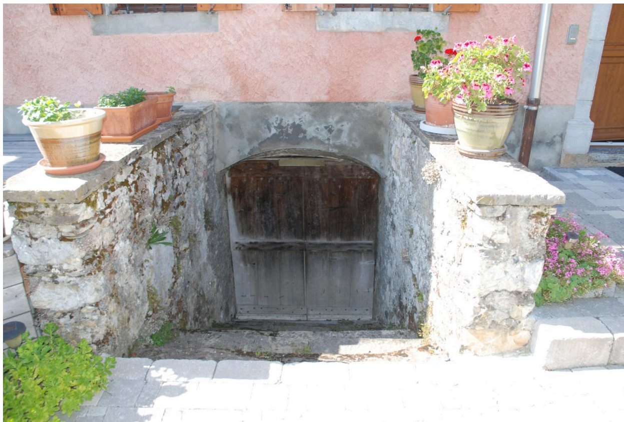
Descente et porte de la cave en sous-sol.
