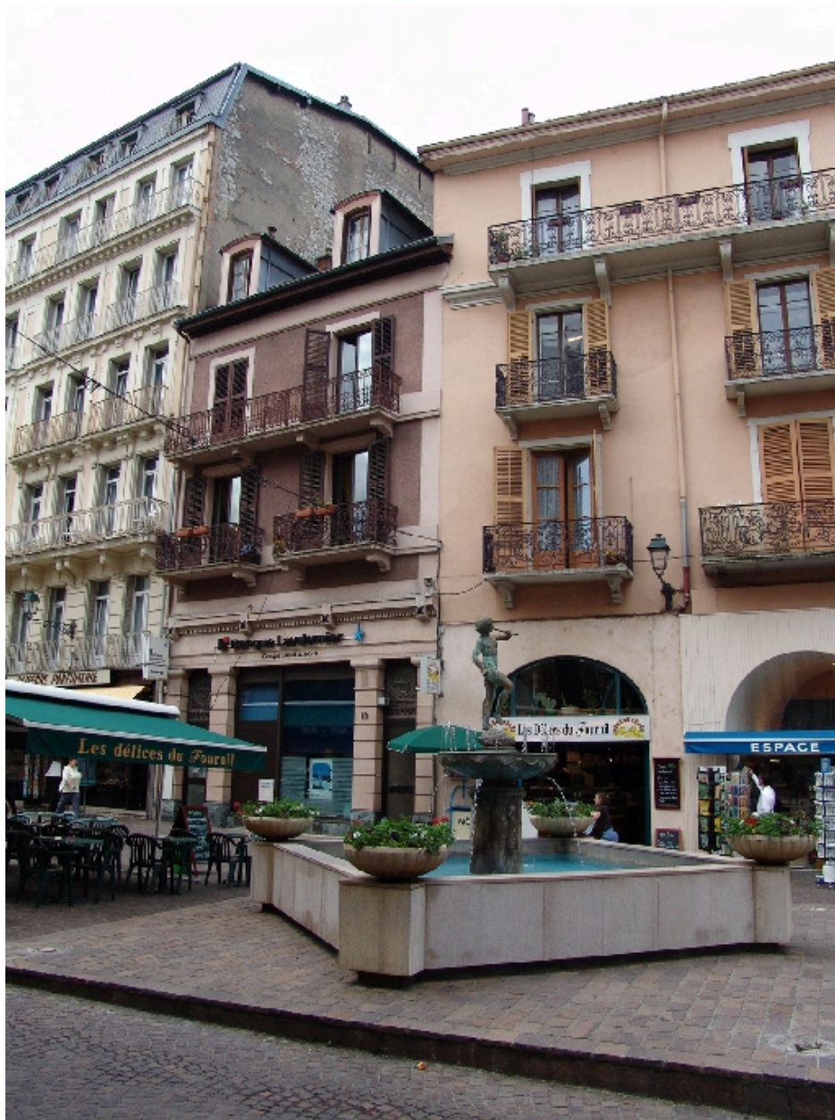
Vue du côté ouest
