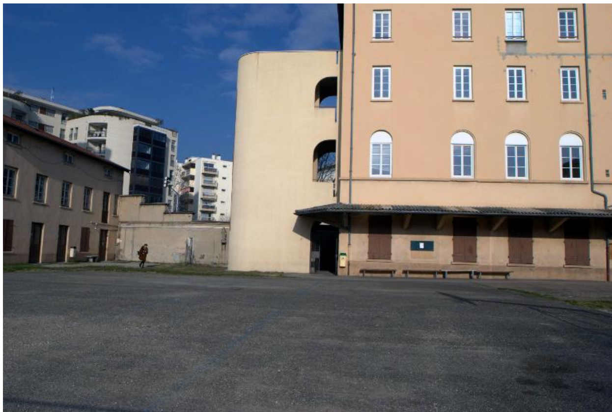
Bâtiment C, élévation postérieure, détail de l'escalier extérieur
