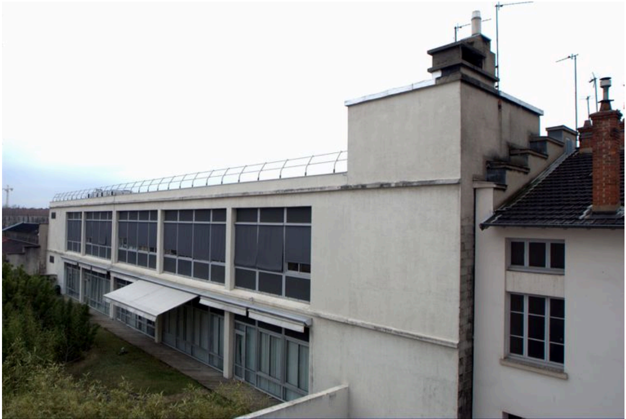
Elévation postérieure, niveaux supérieurs et terrasse
