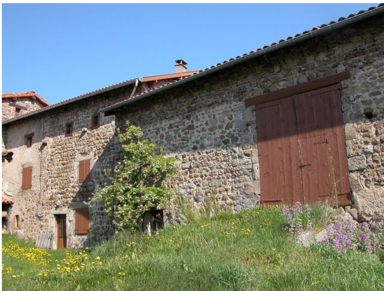
Vue d'ensemble de la partie droite avant de la ferme. Second logis.
