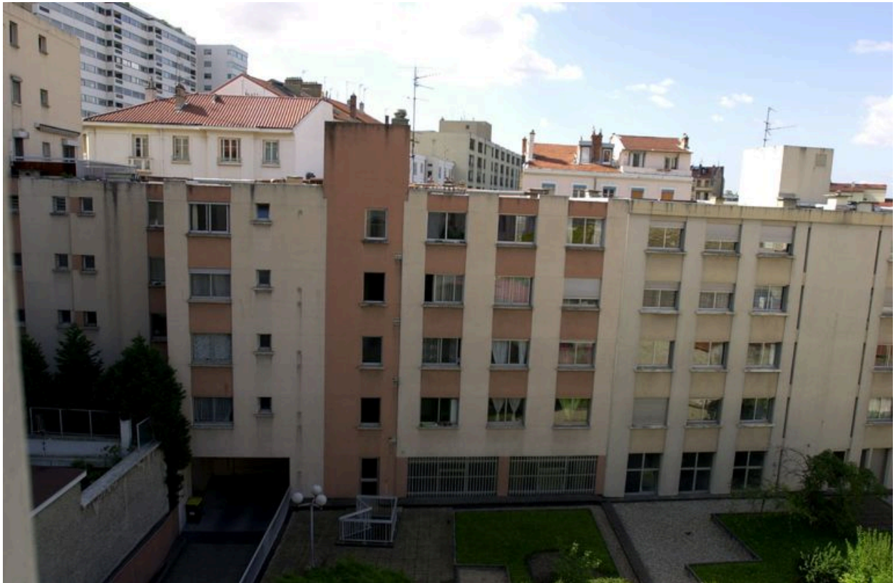
Elévation postérieure du corps de bâtiment rue Rachais
