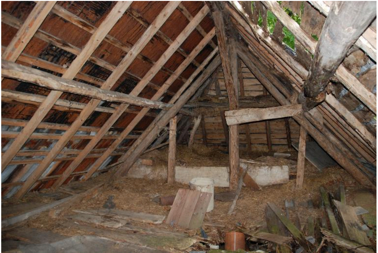
Vue intérieure du fenil sous la charpente.
