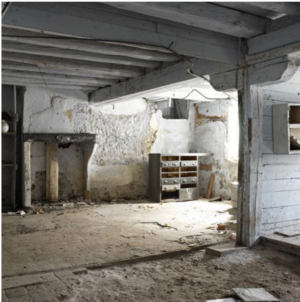
Corps de bâtiment ouest. Partie à droite de la tour d'escalier. Rez-de-chaussée
