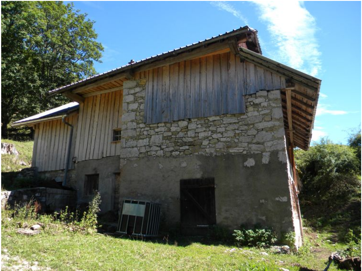
Vue de la façade nord-ouest.
