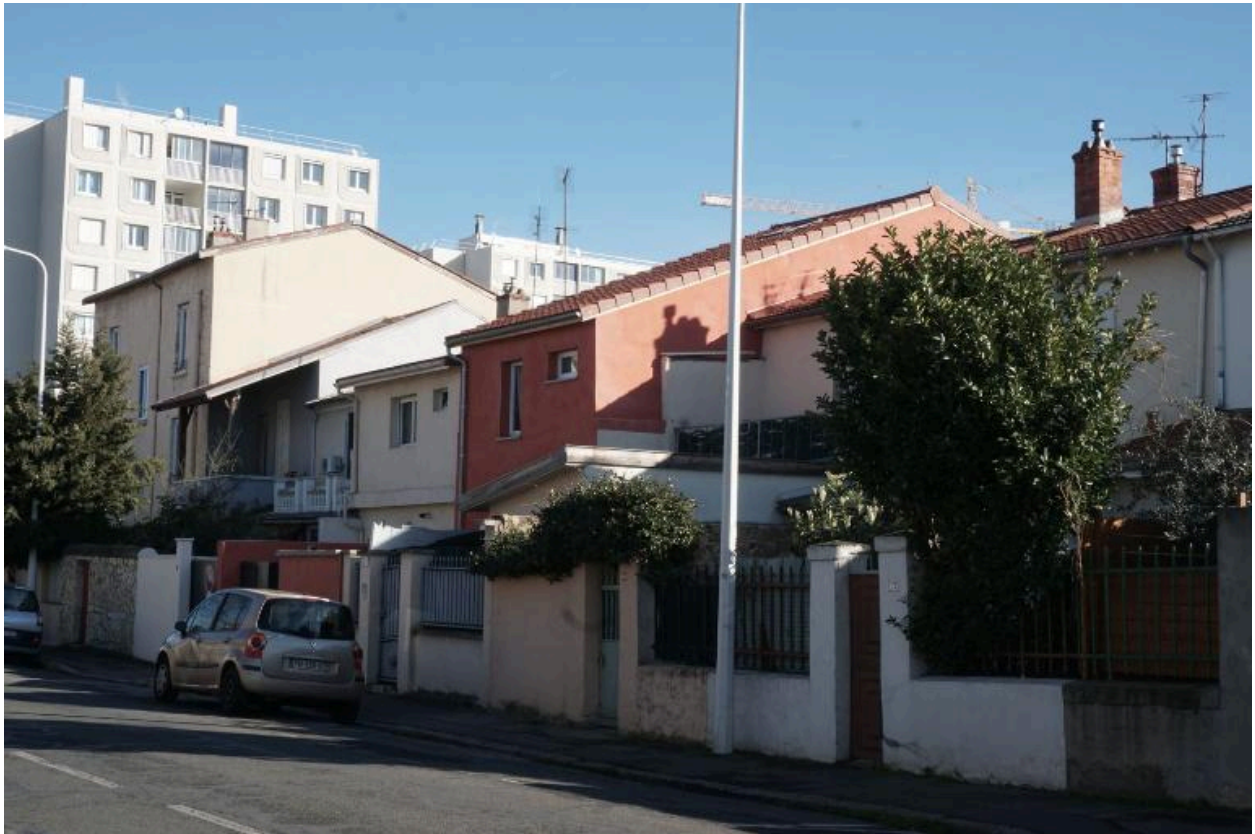
Détail arrière jardins rue de Montagny vue sud
