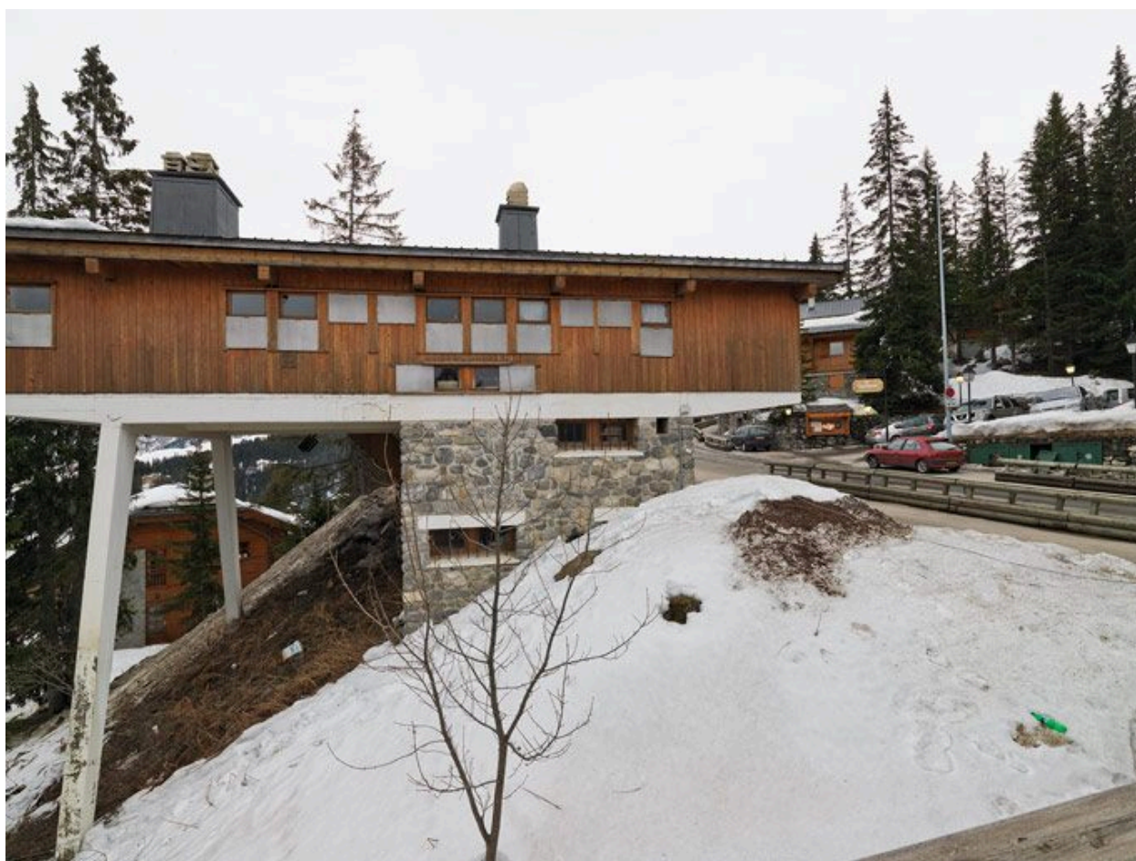
Vue de la façade nord
