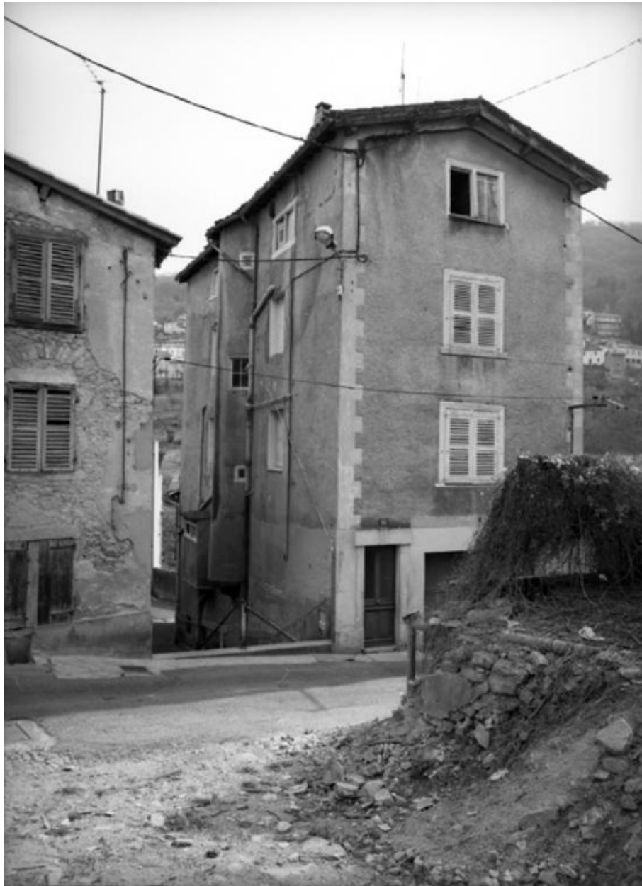
Aspect nord-ouest de la maison avant sa reconstruction et son agrandissement en 2011.
