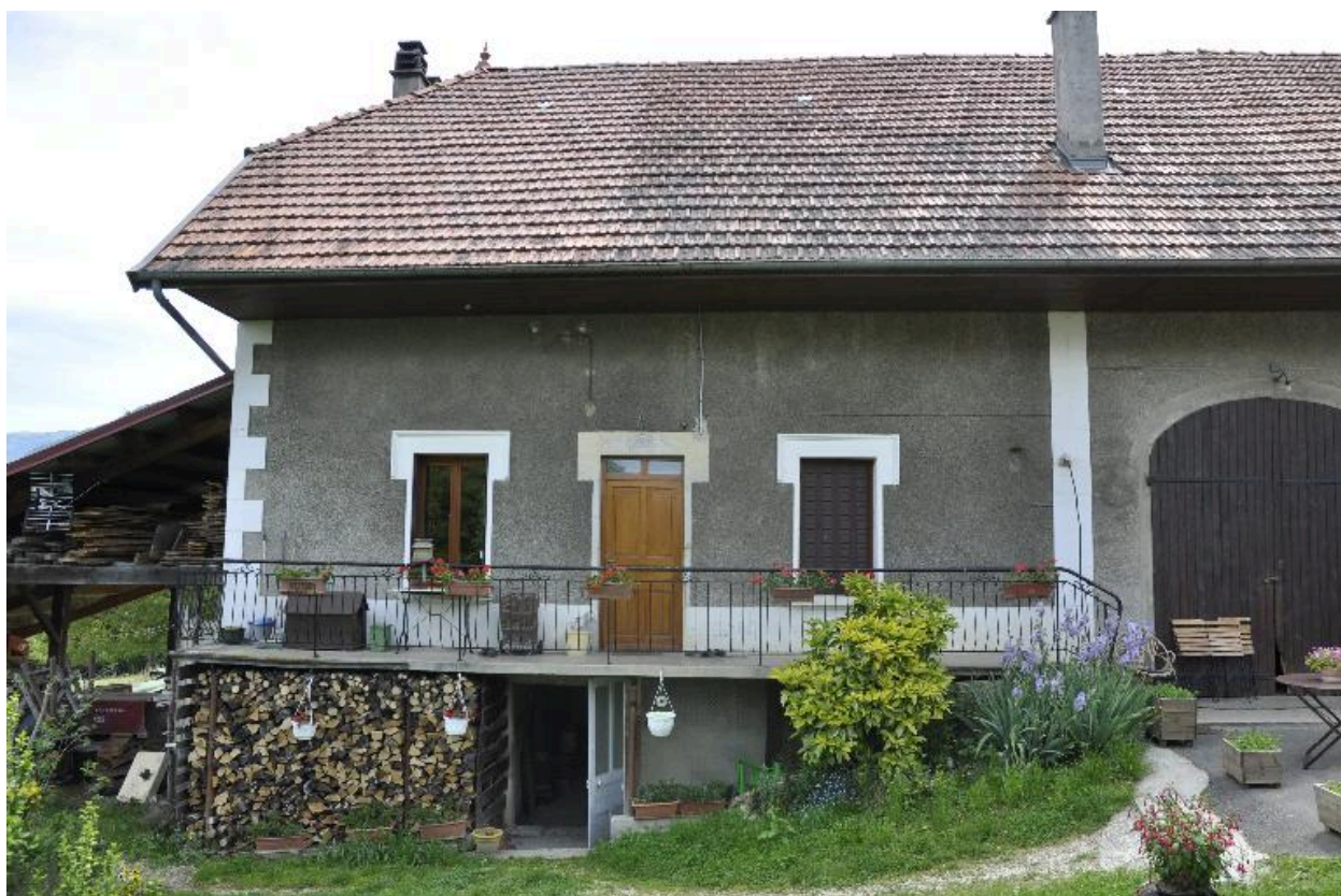
Vue de l'habitation.
