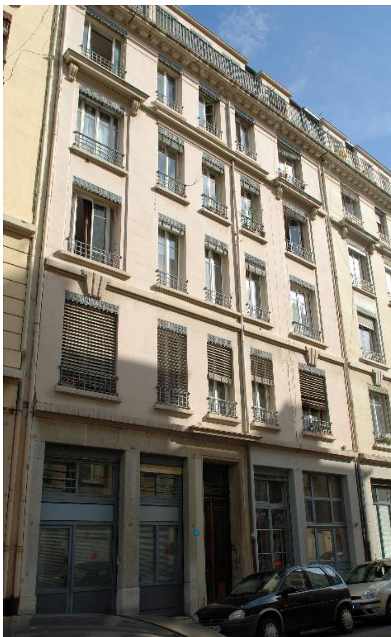
Elévation sur rue : vue générale
