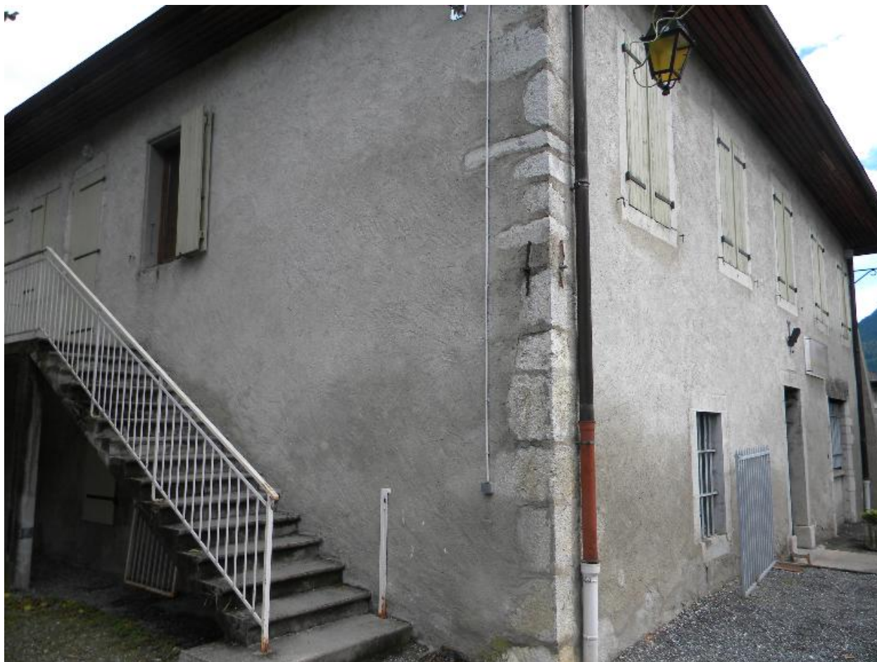
Vue de trois-quarts sud-ouest.
