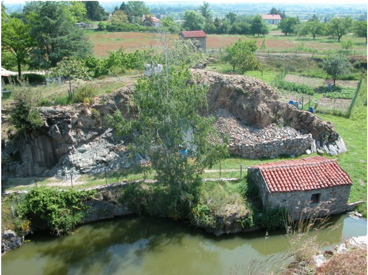
Vue d'ensemble de la pompe (1986 AS 241).
