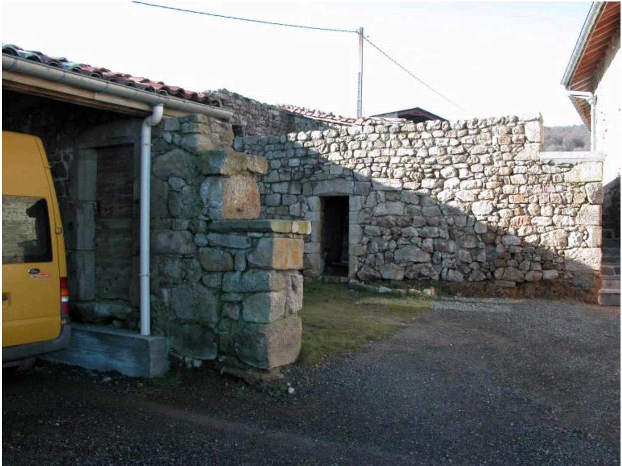
Vestiges d'une bâtiment situé au sud de la grange-étable.
