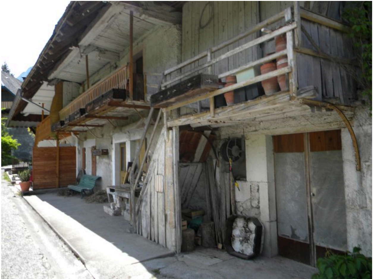
Vue générale de l'alignement de façades sur le gouterreau est.
