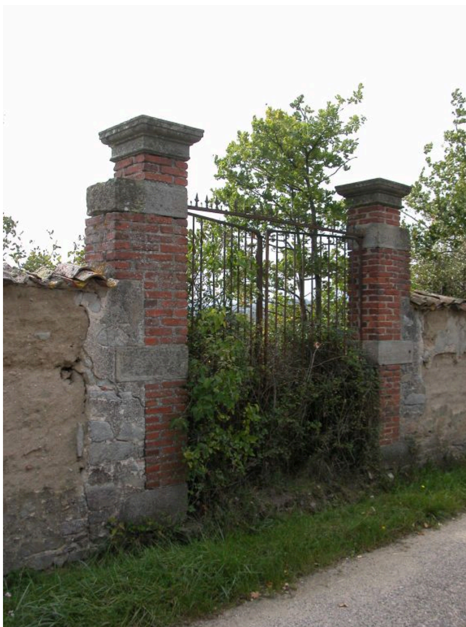
Détail du portail du clos (Montbrison, Moingt, Sous Montagneux, AR 231).
