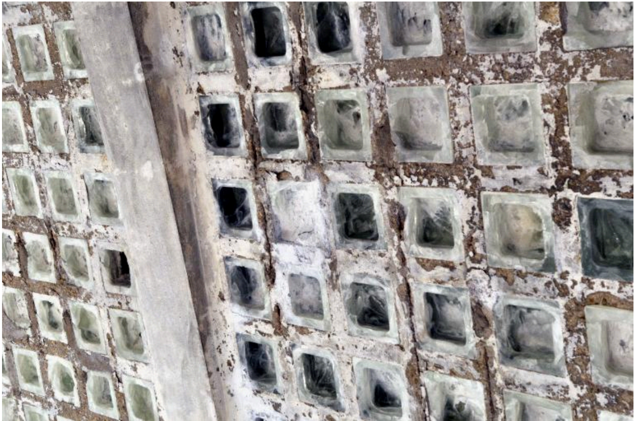
Auvent du bâtiment B : détail (altérations)
