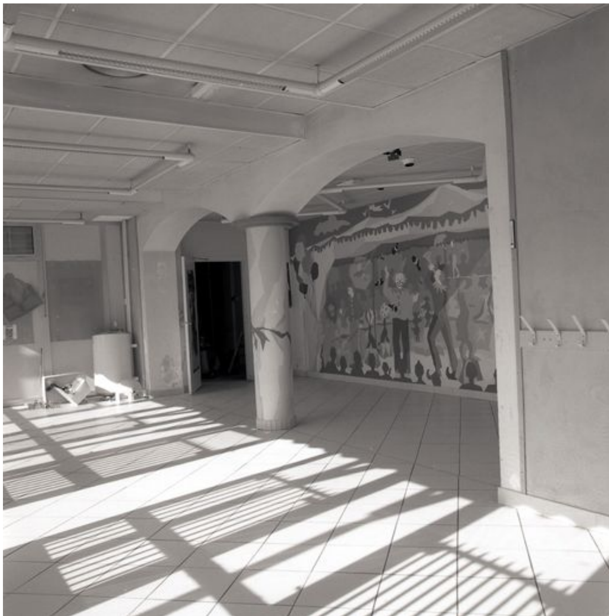
Ecole maternelle. Réfectoire avant restauration
