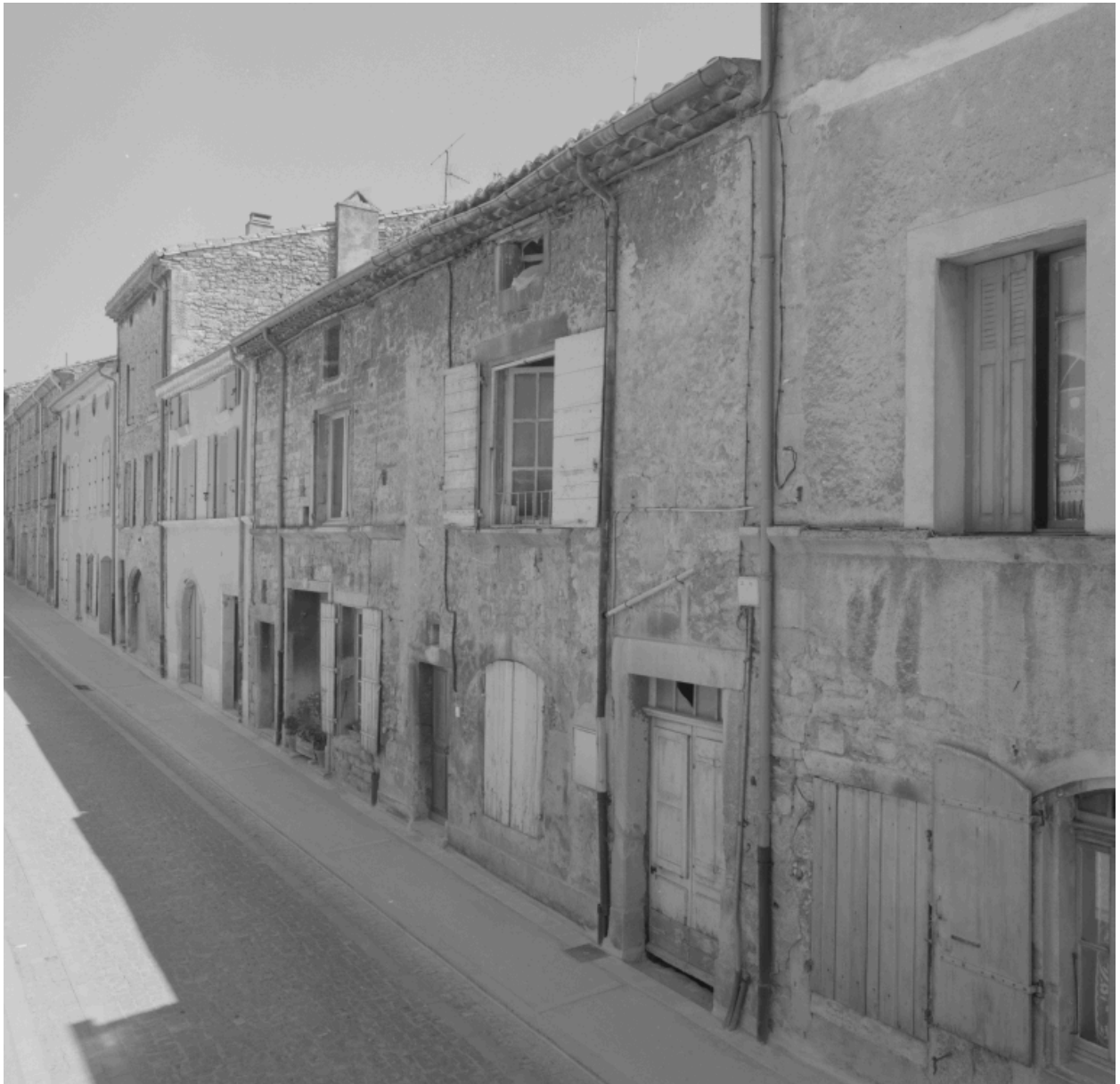
Rue du Grand Faubourg. Façades donnant sur la rue.
