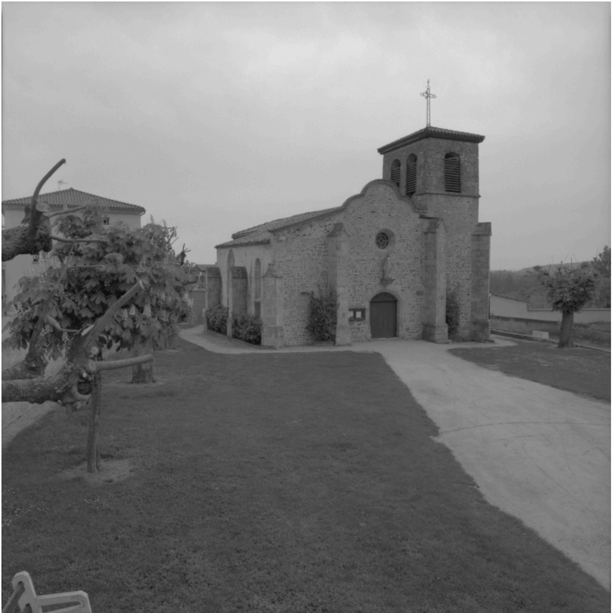
Vue générale de trois-quarts sud-ouest.
