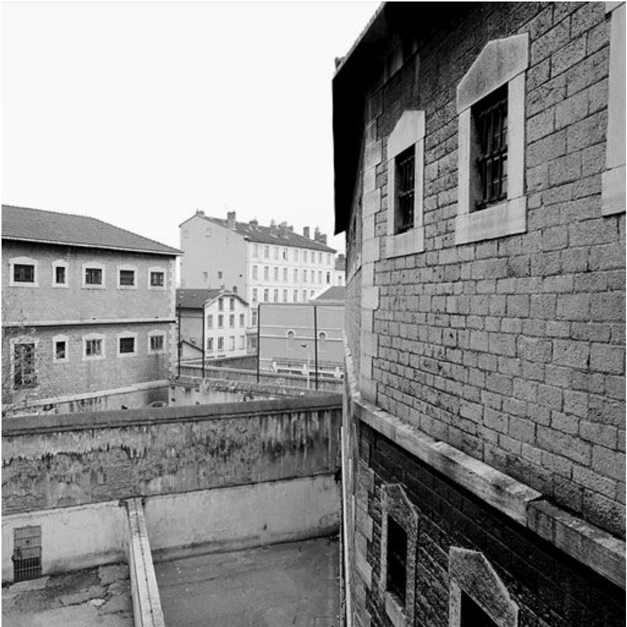
Vue partielle de la prison depuis l'étage de la chapelle. A l'arrière-plan, les immeubles de la rue Dugas-Montbel
