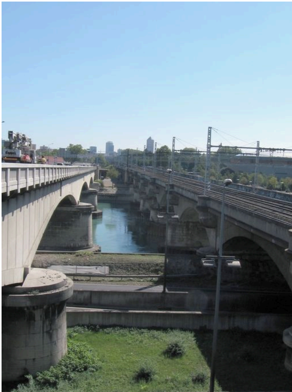
Vue générale, de dessus, face amont (depuis la rive droite) ; le pont Poincaré sur la gauche
