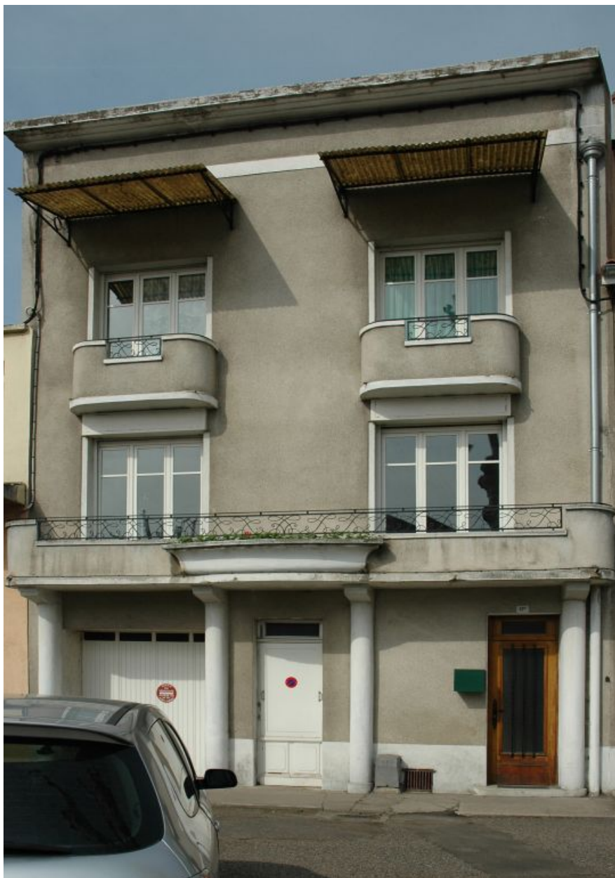
Vue de l'établissement administratif sur le boulevard.
