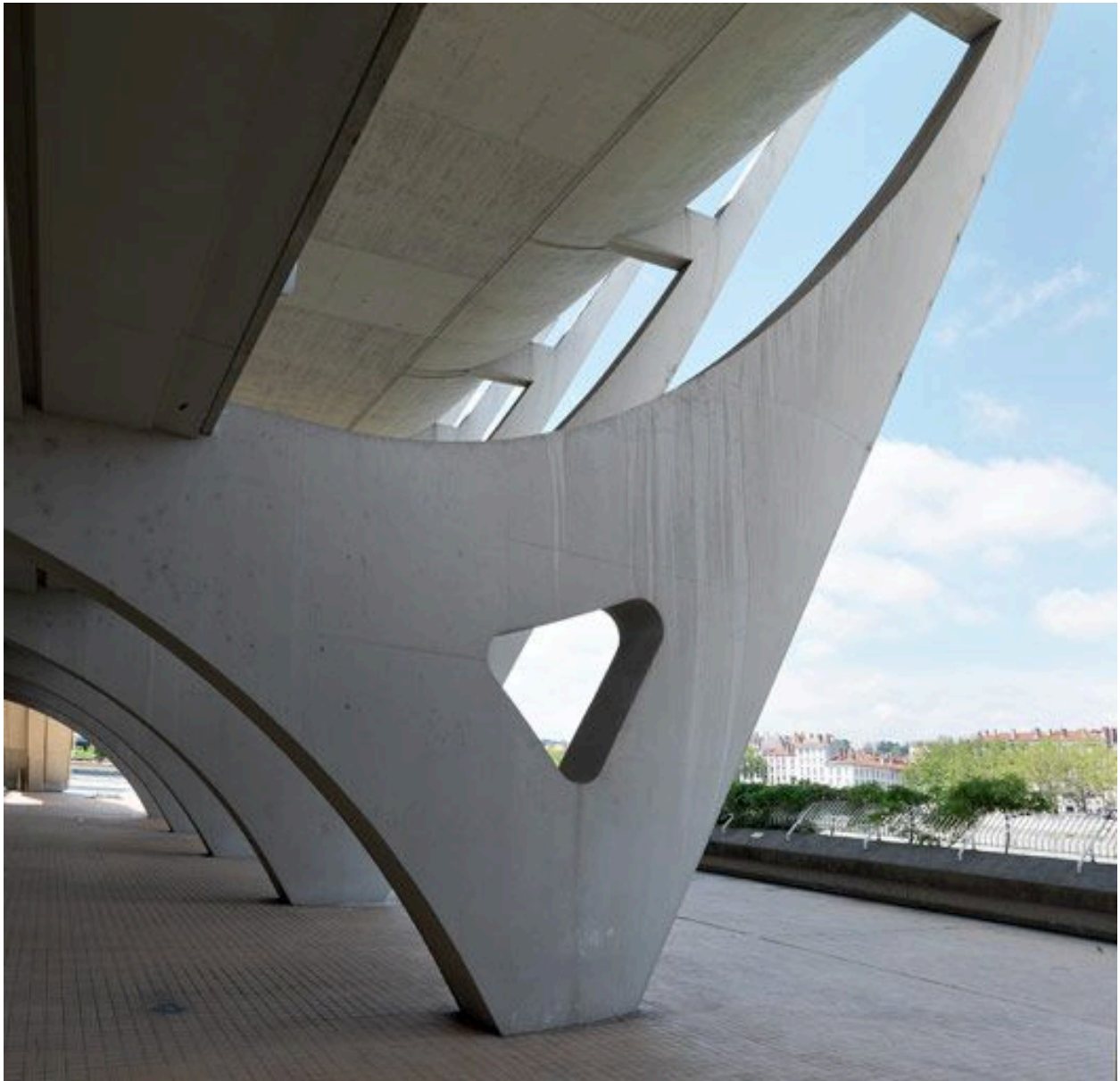
Détail du soubassement du bâtiment d'exploitation (état juin 2012).
