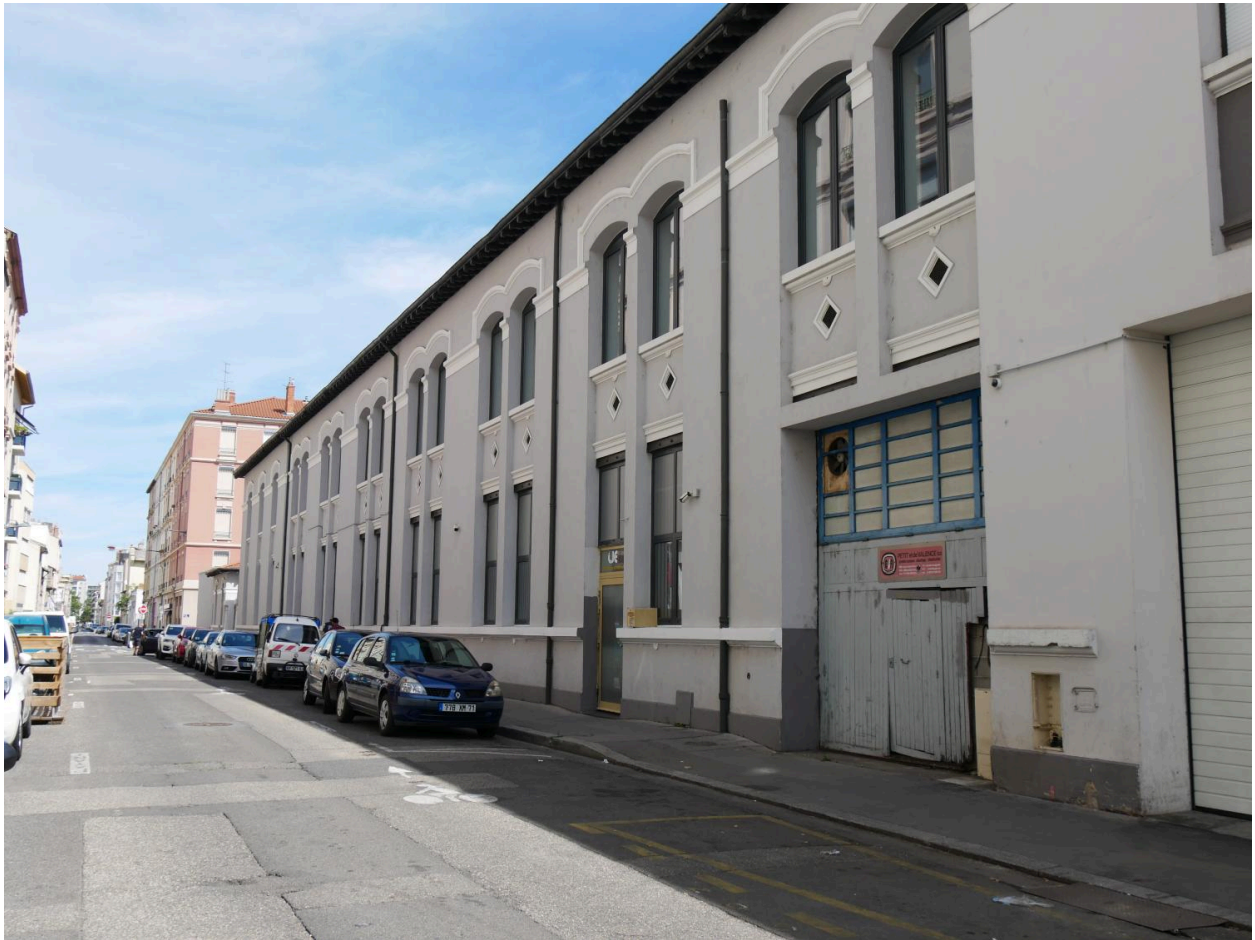
Vue d'ensemble en alignement sur la rue Magenta
