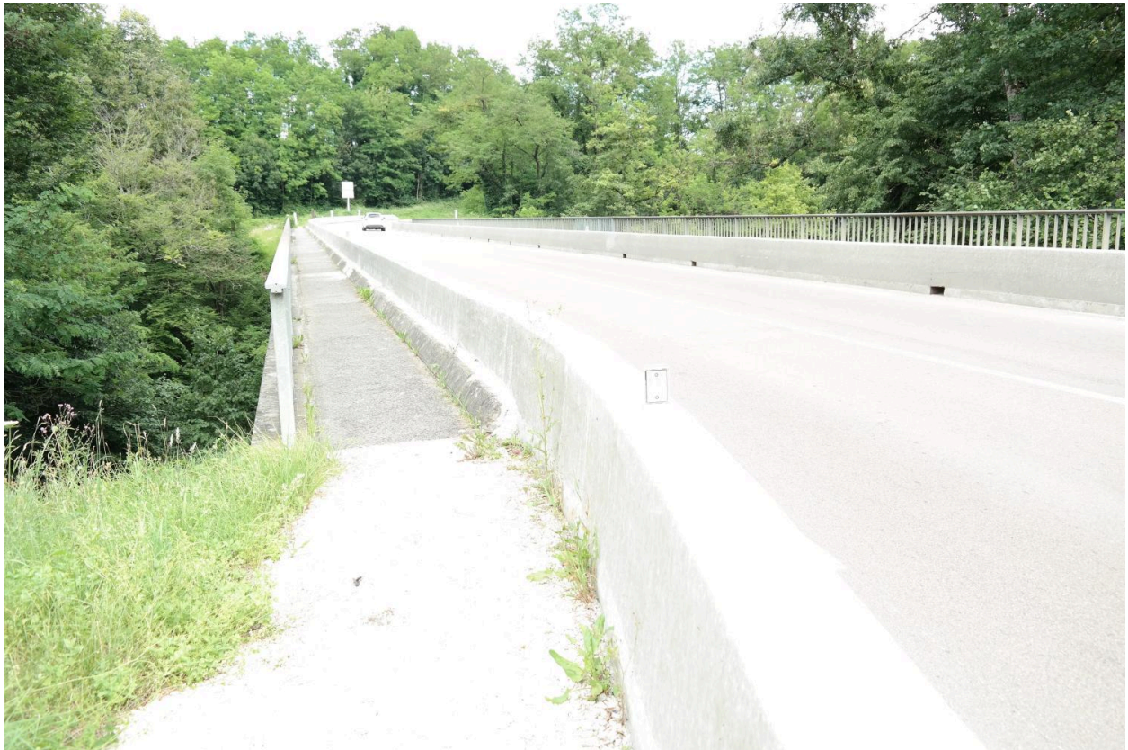
Pont Mottet, détail des trottoirs et garde-corps
