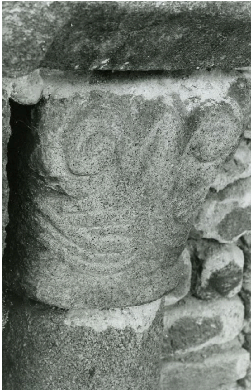
Détail chapiteau de gauche du clocher face sud, avant dernier niveau. Photographie 1ère moitié 20e siècle. SDAP Loire.
