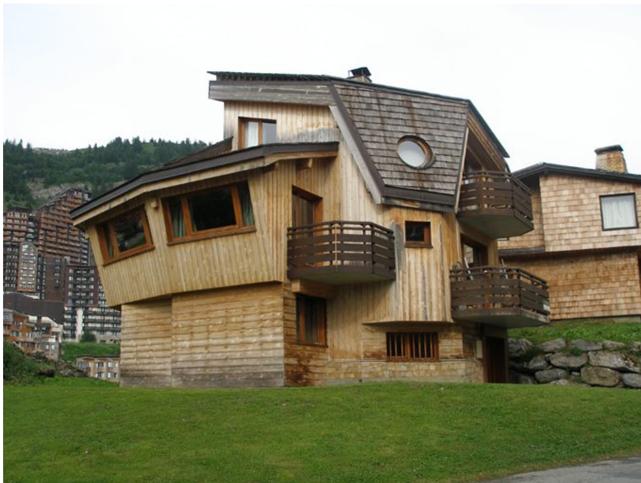
Vue générale depuis le sud-ouest
